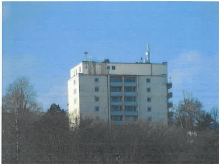
Mobilfunk-Mast Buchbronnenweg 63, Klingenstein
