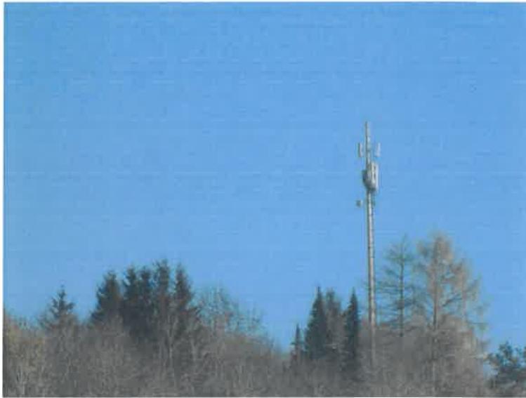
Mobilfunk-Mast Winterhalde, Ehrenstein
